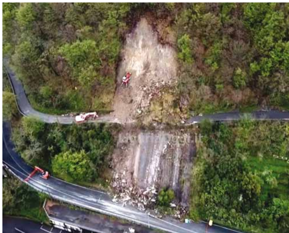
SOPRA: L'immagine ripresa dai droni mostra l'ampiezza della frana che interrompe non solo la Statale 45, ma anche l'unica che porta ad alcune frazioni A LATO: uno dei massi caduti nei giorni successivi
