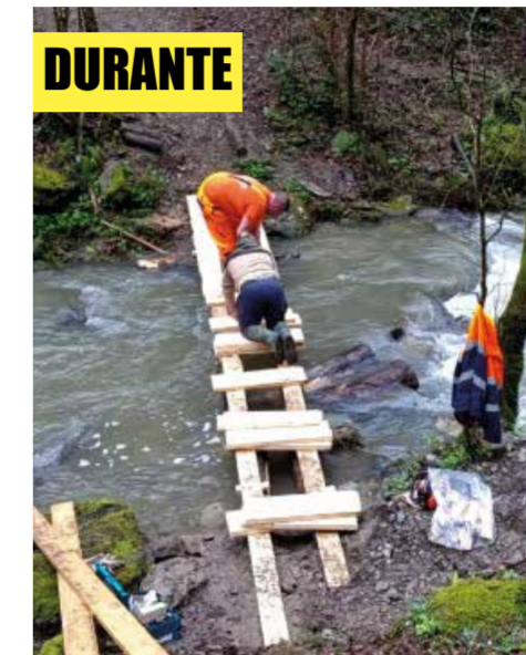
Alcuni esempi di intervento: la riapertura di un sentiero ostruito da un albero caduto e la creazione di una passerella per attraversare un torrente
